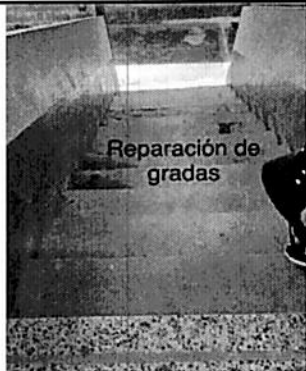
Foto 3: Reparación de gradas en sexto A y B
