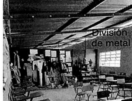
Foto 2: REPARACIÓN DE DIVICIÓN DE METAL EXISTENTE ENTRE LAS AULAS Sexto B y Sexto A
